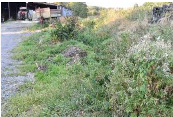
Figure 8. Ruisseau « Le Sté » (relevé A2bis) longeant la cour d'une ferme, recevant des eaux d'égout et encombré de déchets divers.
